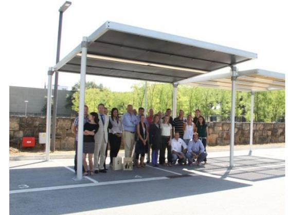
Pérgola modular; para mayor flexibilidad de instalación, las columnas se pueden situar en cualquier punto del perímetro de la cubierta. Las diferentes soluciones de cubierta ofrecen diferentes grados de protección y, en el caso de la cubierta fotovoltaica, generar energía.
